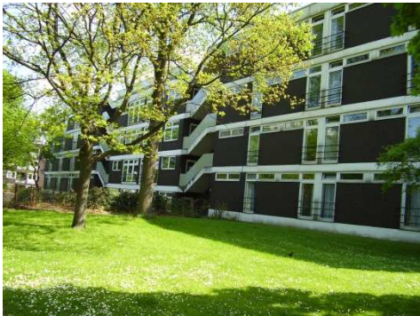
Wohnheim „Rosenbachweg 10-12“ - Rückansicht -
